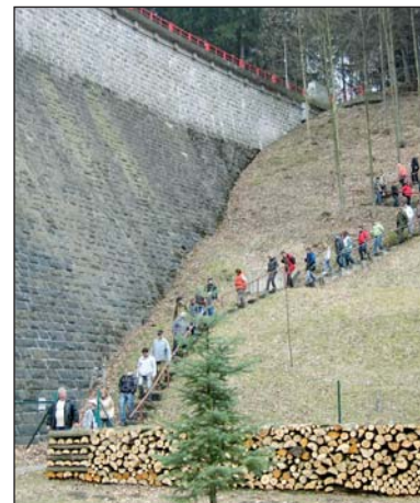
U příležitosti Světového dne vody uspořádalo Povodí Moravy v sobotu 26. března Den otevřených dveří na vodním díle Bystřička. Bylo zajímavé podívat se do míst běžně pro nás laiky nepřístupných, například do vnitřních prostor hráze.
